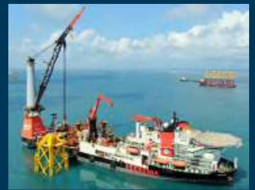
Πλοία εγκατάστασης τριπόδων
