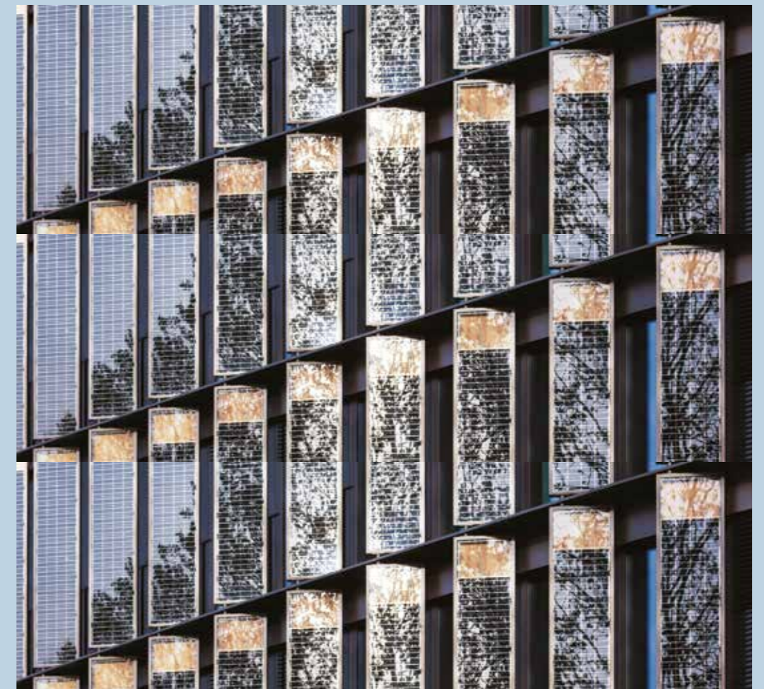
Μετατρέποντας τα κτίρια από καταναλωτές σε παραγωγούς ενέργειας: Τα κατακόρυφα Φ/Β μπορούν να παίξουν ρόλο ρυθμιζόμενων σκιάστρων
